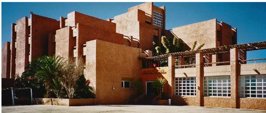
Hôtel Abdeslem Faraoui conçu par l'architecte Patrice de Mazières (1930-2020)
